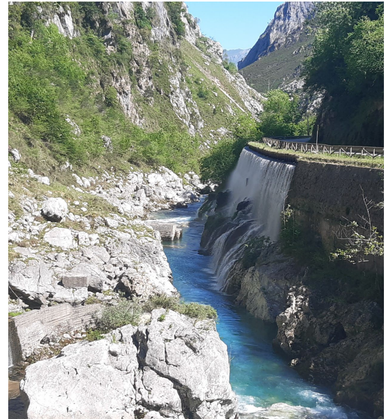
Río Cares aguas abajo del azud de Poncebos
